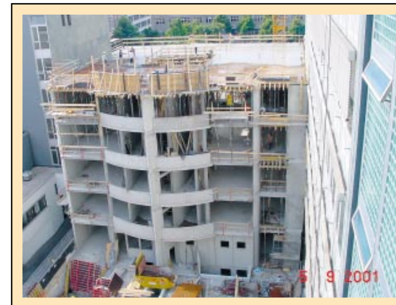
Baustelle Henke Moden, Berlin Kurfürstendamm
