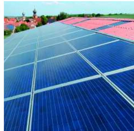
*Stromerzeugung auf dem Dach, Photovoltaik-Elemente anstelle von Dachpfannen.*
