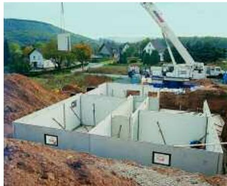
Ein absolut wasserdichter Keller an einem Tag.
