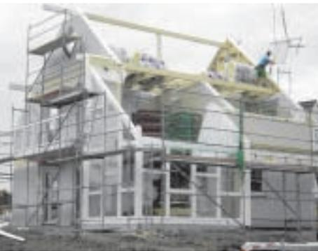
inklusive Fenster, Rollläden, Elektro-, Heizungs- und Sanitär-Vorinstallation witterungsgeschützt in einem unserer Werke hergestellt. Ergebnis dieser Phase ist das „vorgefertigte Haus“.
